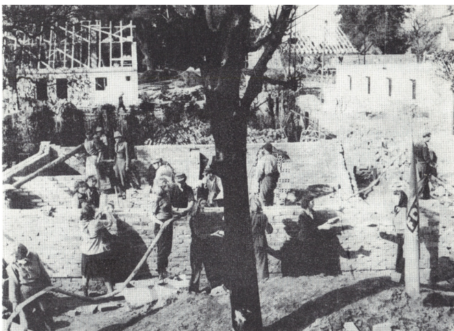
Emsiges Treiben auf einer der Baustellen in Gingst
